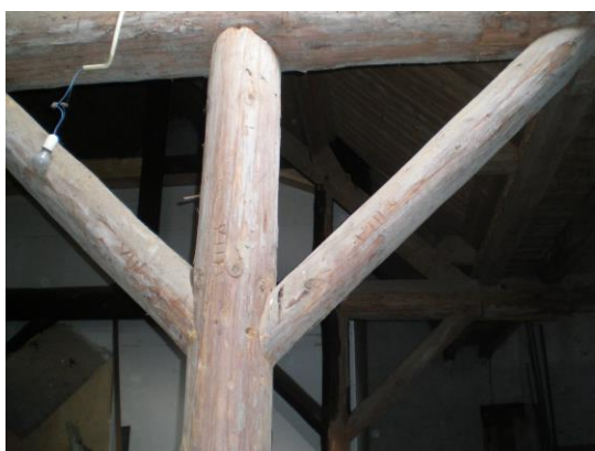
Afb. 17 Merktekens in de gebinten en pinnen als verbinding
