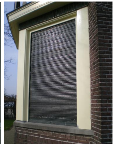
Afb. 26 Rolluiken in de driezijdige erker
