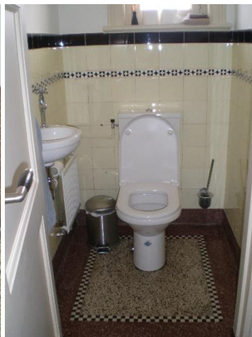
Afb. 15 Combinatie van granito en tegeltjes
